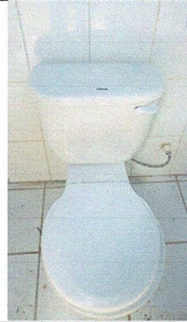
Foto 4: REPARACIÓN, MANTENIMIENTO Y MEJORAMIENTO DE SERVICIOS SANITARIOS.
