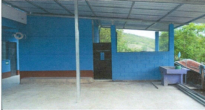
Foto 1: MEJORAMIENTO INSTALACIÓN DE ESTRUCTURA PORTANTE METÁLICA (TIPO PORTICO) Y CUBIERTA DE TECHO CON LÁMINA TROQUELADA CALIBRE 26 PARA COCINA.
